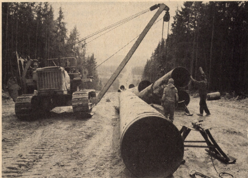
GÁZVEZETÉKCSÖVEK FEKTETÉSE
