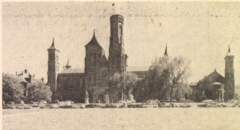
A „KASTÉLY” ÉPÜLETE WASHINGTONBAN
